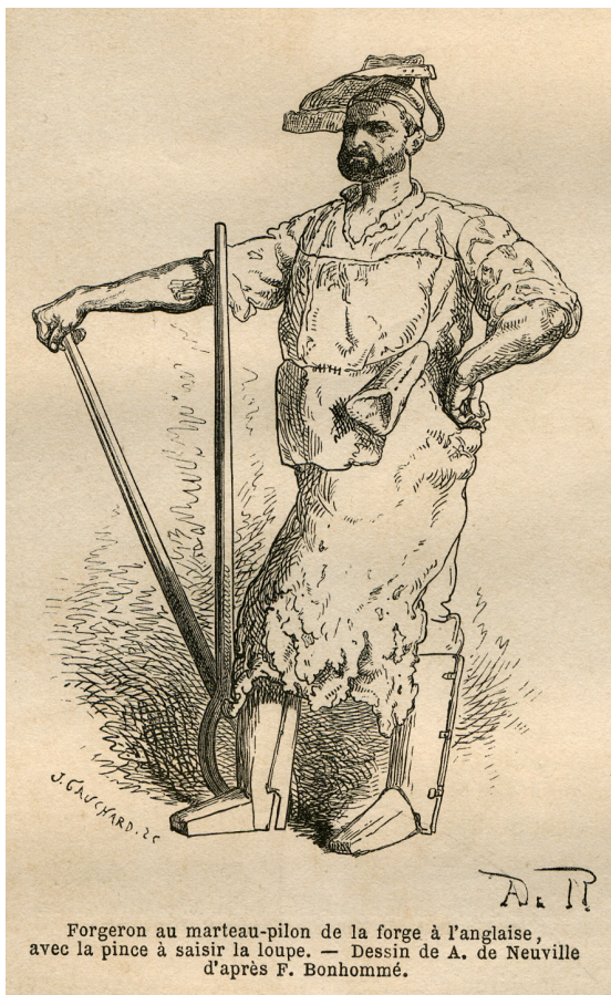
Illustration 2 : A. de Neuville d'après François Bonhommé Forgeron au marteau-pilon de la forge à l'anglaise avec la pince à saisir la loupe dans Le Tour du Monde, Le Creusot et les mines de Saône-et-Loire, Textes de L. Simonin, 1867, premier semestre, p. 183 Collection particulière. Reproduction Francis Dubuc
