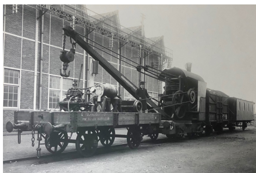
Système de levage sur rail Schneider et Cie, en cours d'expérimentation aux usines Schneider et Cie, à Harfleur, (actuel département de Seine-Maritime). Photo prise le 13 décembre 1911. Collection Académie François Bourdon, au Creusot.
