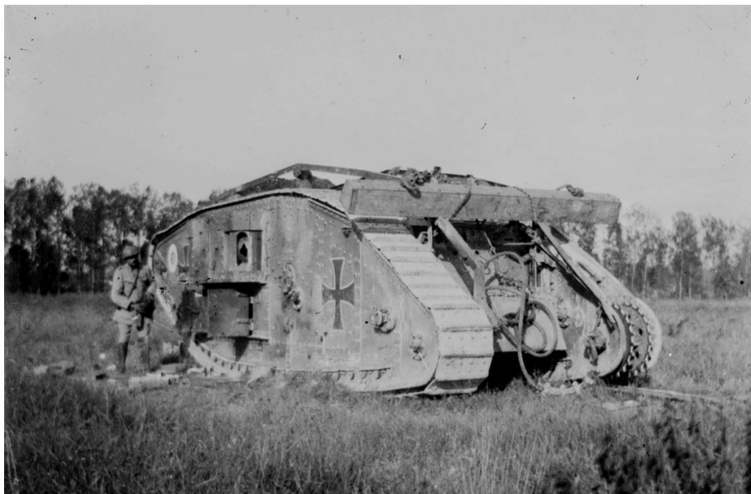
Tank britannique (Mark IV avec marquage allemand car capturé puis utilisé par les troupes ennemies), sous la garde d'un soldat français. La destruction de la chenille droite a mis à jour le double Barbotin. Agence Rol, 1918, Gallica.fr, Bibliothèque nationale de France.
